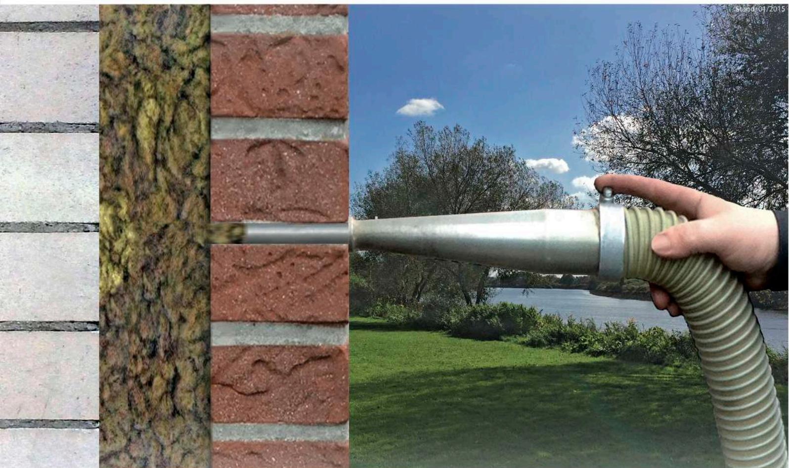
**Bemessungswert der Wärmeleitfähigkeit  $\lambda = 0,038 \text{ W/mK}$**
